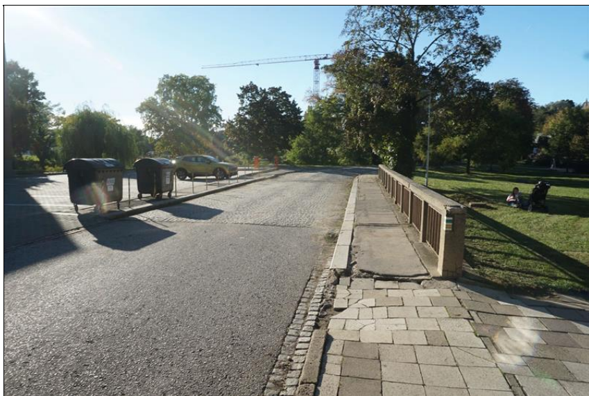
Celkový pohled na most proti směru staničení.
