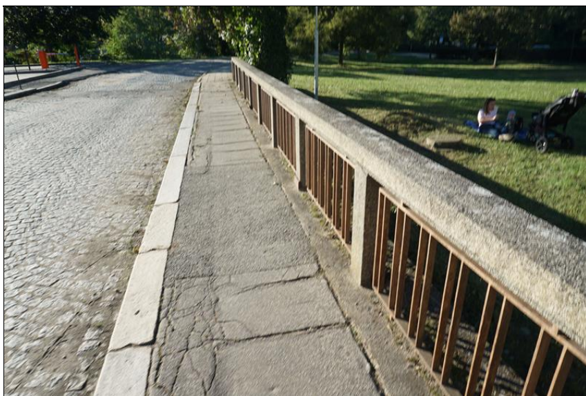
Pohled na levé zábradlí proti směru staničení.
