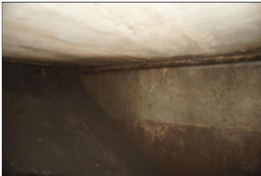
Pohled na opěru OP2
