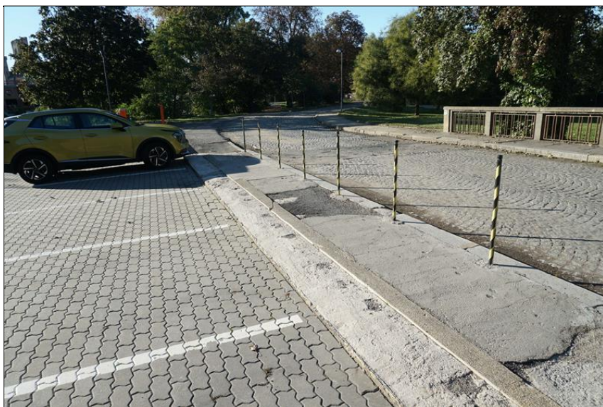
Celkový pohled na pravou stranu mostu.
