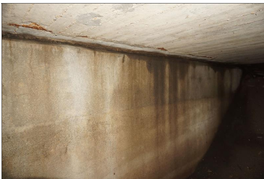
Pohled na opěru OP1
